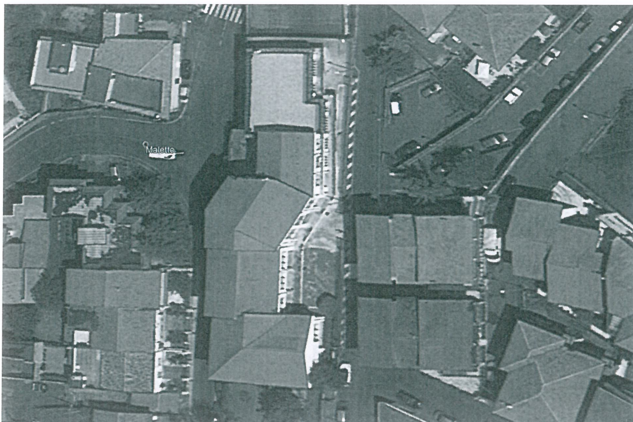
Vista dall'alto dell'edificio
